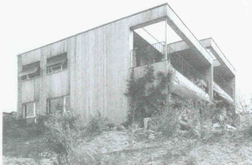
Obr. 2: Fasáda plně vystavená působení povětrnosti
